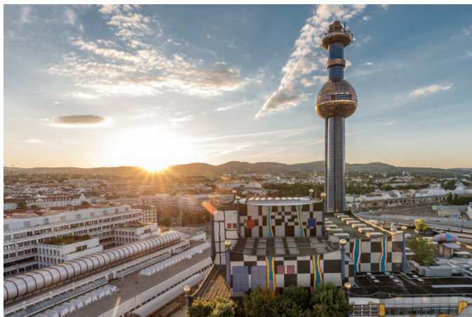
Foto: Wien Energie
